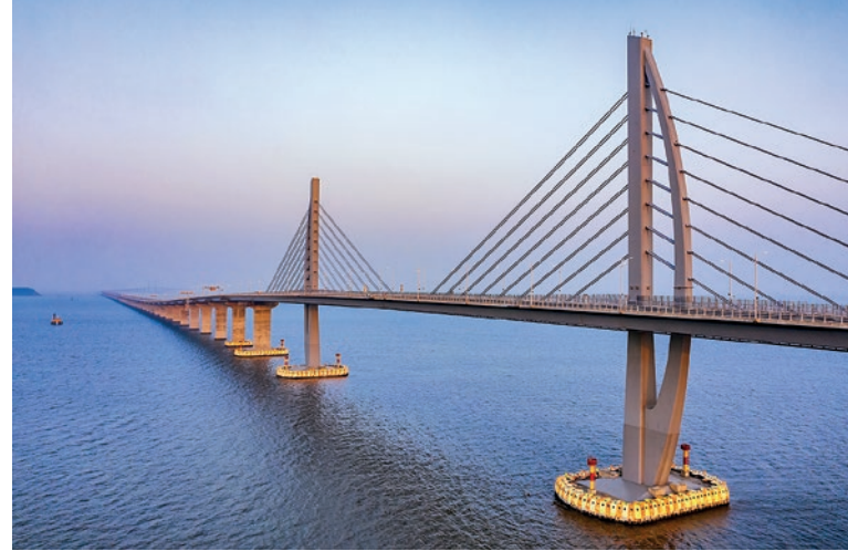
全长55公里的港珠澳大桥是世界上最长的跨海大桥，主体工程集斜拉桥、人工岛、海底隧道于一体。
